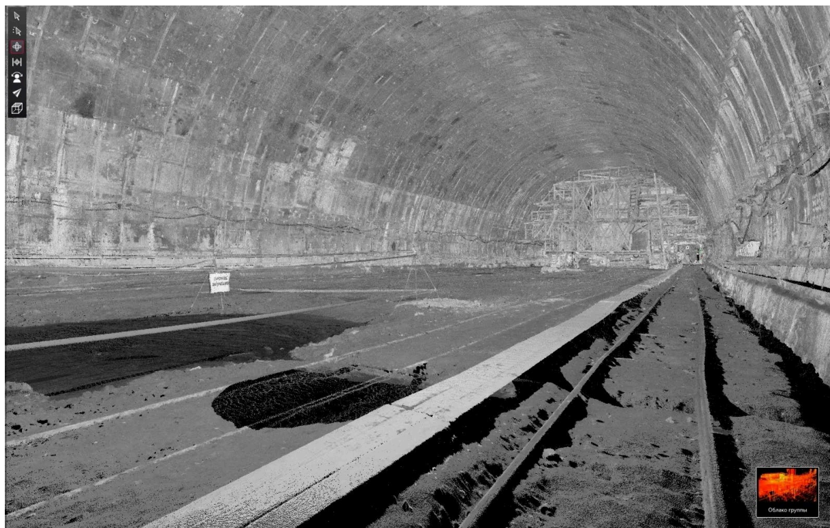
Рис. 5. Облако точек тоннеля большого сечения с монолитной обделкой (по данным лазерного сканирования) [12]
