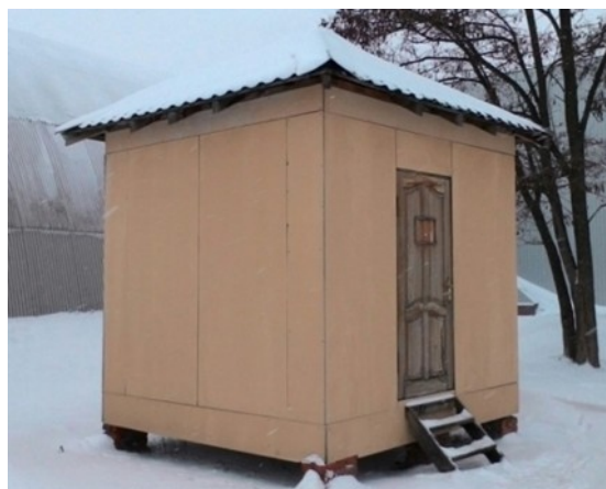
Рис. 1. Общий вид экспериментального строения
