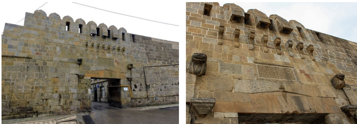
Рис. 2. Северная стена. Кырхляр-капы Fig. 2. The Northern Wall. Kyrkhlyar-kapa
