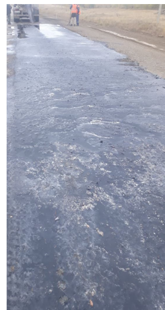
Рис. 2. Проезжая часть после распределения жидкой суспензии в виде тонкого обеспыливающего слоя Fig. 2. Road surface after spreading the suspension slurry as a thin dedusting layer
