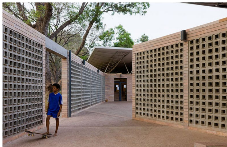
Рис. 2. Строительство стен в Национальном парке Мали [9] Fig. 2. Wall construction of the National Park of Mali [9]
